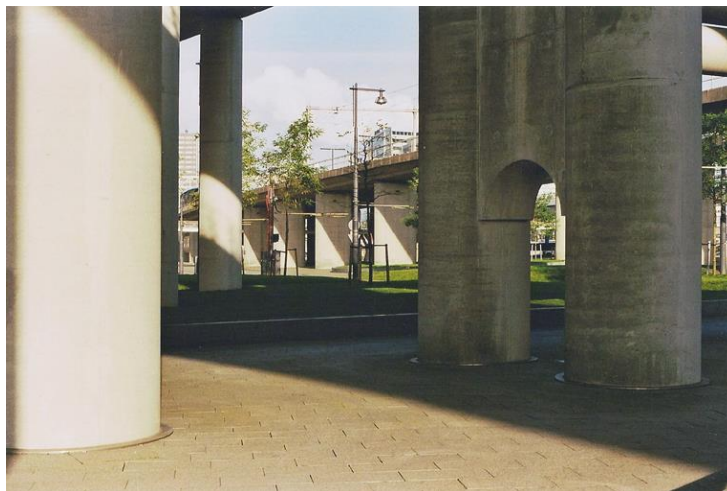
Afbeelding 1: kale betonnen kolommen en bestrating onder de spoorwegen in Sloterdijk
