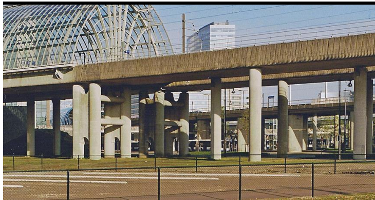
Afbeelding 2: kale betonnen kolommen en bestrating onder de spoorwegen in Sloterdijk
